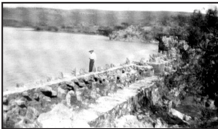
- LA PRESA DEL CUBO. - PRIMERA ETAPA.
