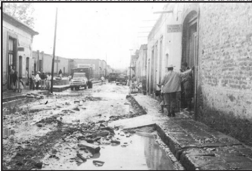
CALLE HIDALGO FOTOGRAFÍA DE LA INUNDACIÓN DE 1958
