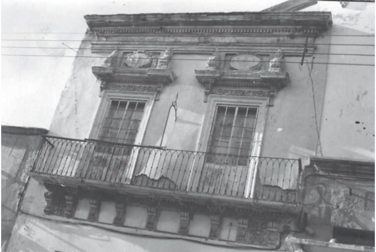
MARCOS DE VENTANAS Y BALCÓN EN LA PLANTA ALTA DE UNA CASA DEL LADO NORTE DEL JARDÍN DE LA CONSTITUCIÓN
