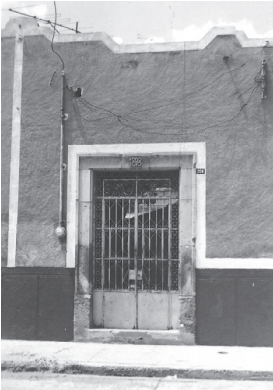
CASA EN CALLE MINA. ESTA CASA TIENE GRABADA UNA FECHA: 1898, QUE PROBABLEMENTE SEA LA DE SU CONSTRUCCIÓN
