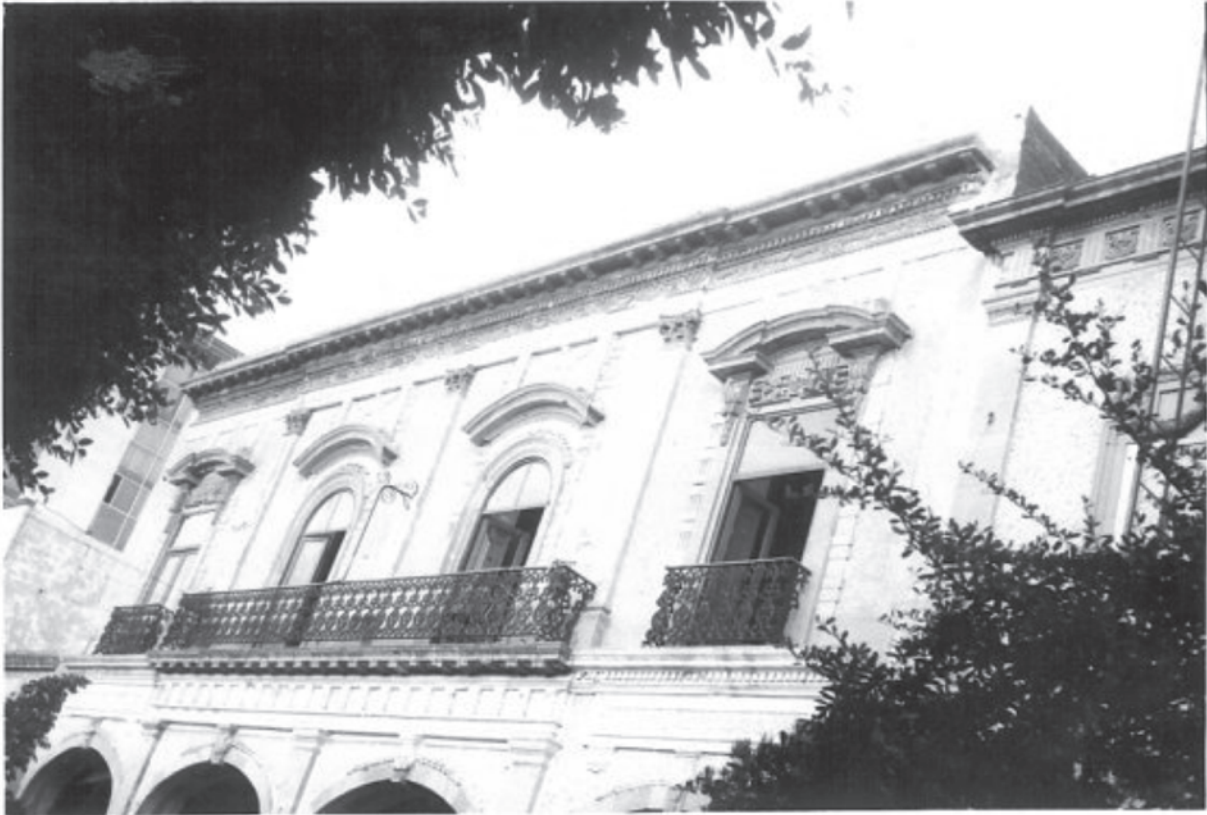
CASA EN PORTAL JOSE ROJAS GARCIDUEÑAS. ESTA CASA ES NOTABLE POR TENER SU FACHADA DE PLANTA BAJA EN ESTILO BARROCO, INTERIORES Y PORTADA DE PLANTA ALTA CON ELEMENTOS NEOCLÁSICOS Y PRIMER PATIO CON ARCOS NEOGÓTICOS
