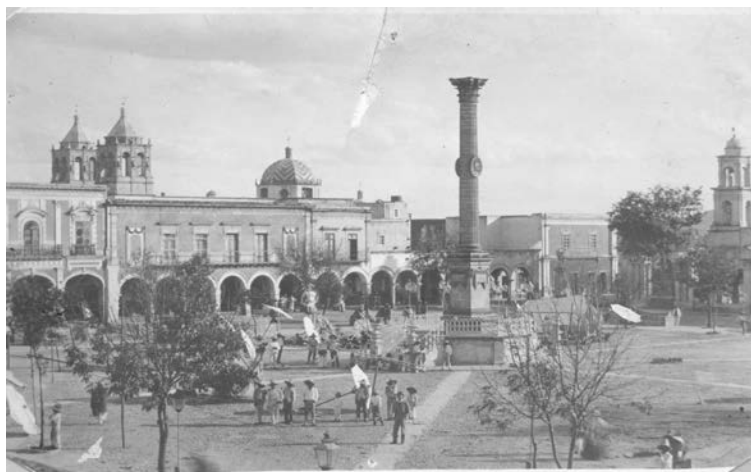
FOTOGRAFÍA ANÓNIMA DE LA COLUMNA LLAMADA PIRAMI
