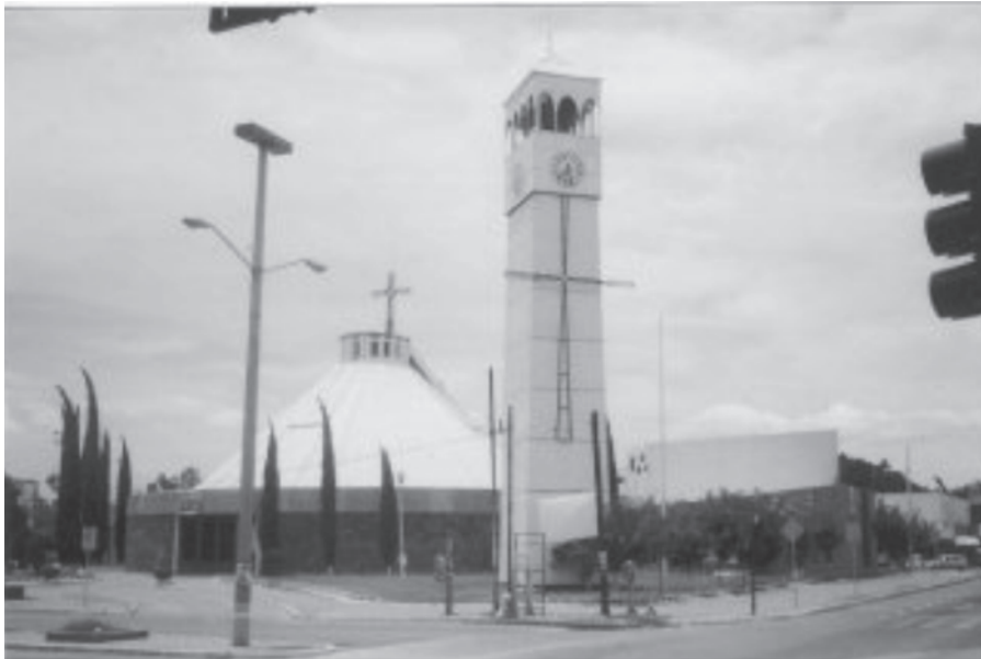
PARROQUIA DEL SAGRADO CORAZON. PRIMER TEMPLO QUE ROMPIÓ CON LA PLANTA TRADICIONAL EN CRUZ LATINA. SE CONSTRUYÓ EN FORMA CIRCULAR
