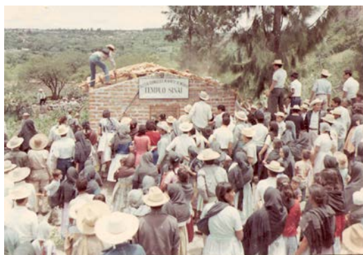
Destrucción del Templo Sinaí. 28 de julio de 1968
