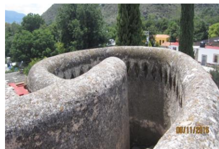
Escalera de caracol para subir al campanario
